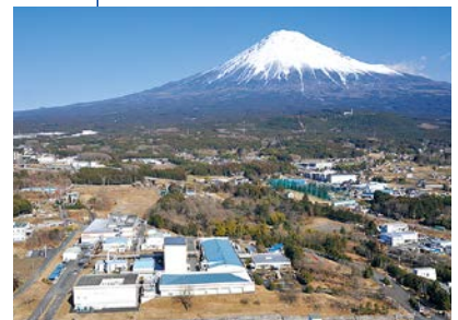
フジヤマ工場
